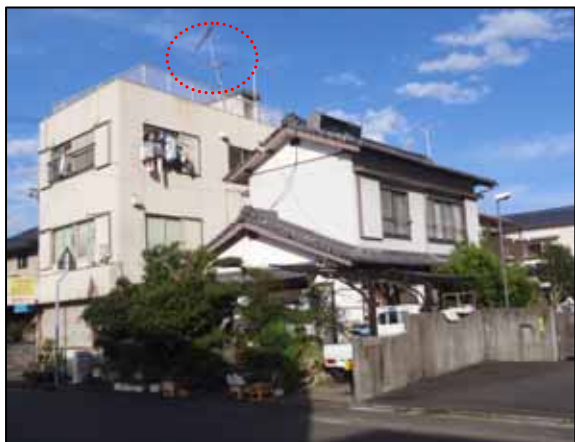
図 4-1 撮影場所 アンテナが北方向に曲がっている。
