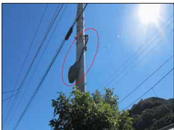
図 4-5 撮影場所 電柱に設置された街灯部が時計回りに巻きついている。
