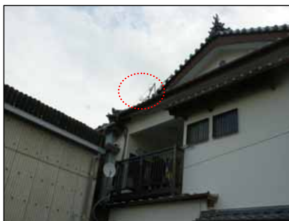
図 4-6 撮影場所 土佐清水市役所提供 アンテナが西方向に曲がっている。
