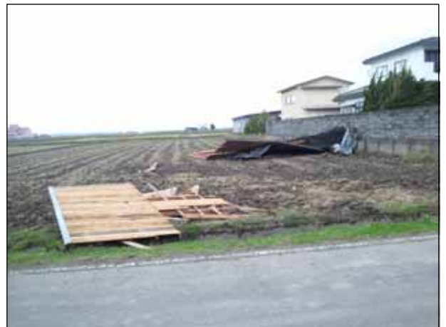
飛散した写真の作業小屋の屋根 (南から撮影)
