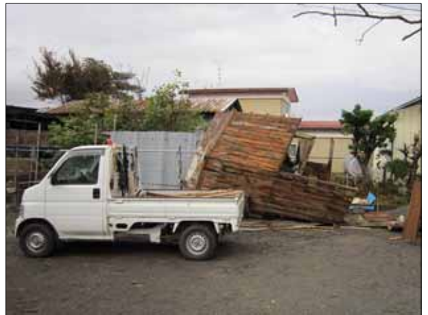
倒壊した物置小屋 (倒壊方向不明) (西から撮影)
