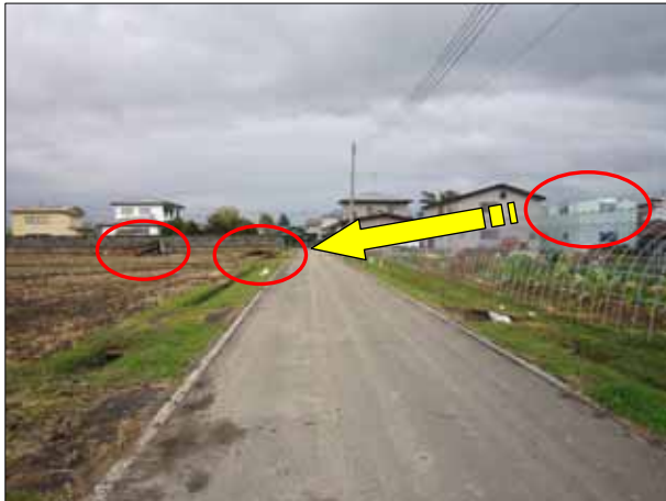
作業小屋の屋根が北北東方向約 50m 先の 水田に飛ばされた (西から撮影)
