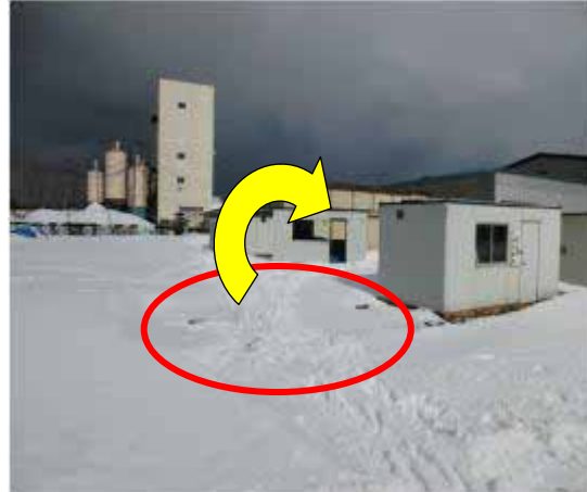
北東方向に飛ばされたプレハブ小屋 (南西から撮影)
