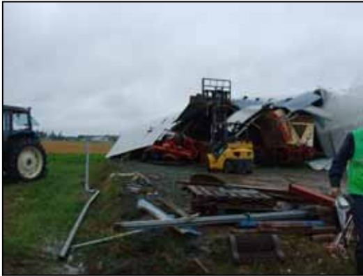
写真 -1- (地点1、北北東方向を撮影) 倒壊したD型倉庫。棟の向かって左奥を支点に棟全体が反時計回りに向きを変えた。地面に引きずった痕跡はない。これに伴い倉庫内のトラクター1台が横転し、その横の1台も破損。
