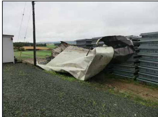
写真 -5- (地点5、北北東方向を撮影) 住居東側の電柱および電線にひっかか っていた飛散した屋根板。
