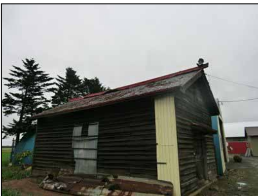
写真 -8- (地点8、北西方向を撮影) トタン屋根の半分程度が剥離し、東南東方向へ131m飛散した倉庫。
