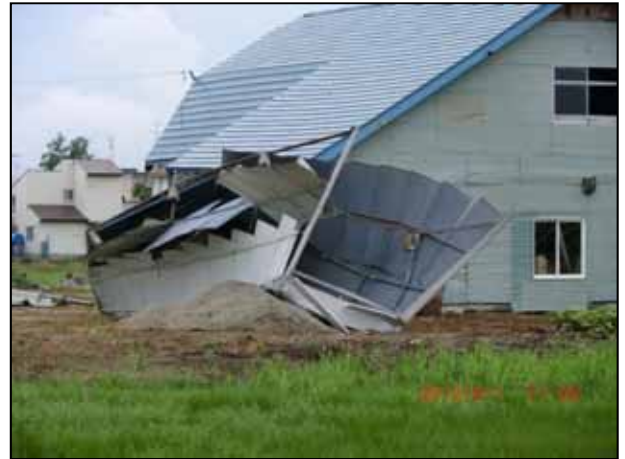
北東方向に飛散したプレハブ車庫
