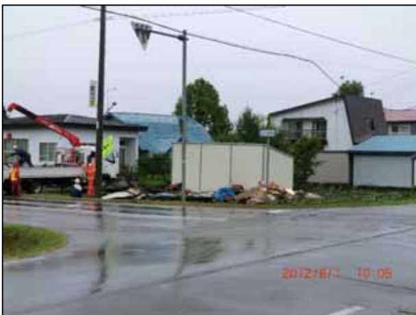
南東方向に倒壊したプレハブ車庫
