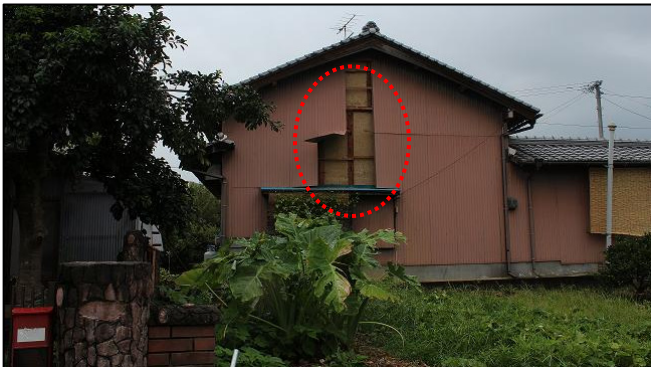
図 4 - 11 撮影場所⑪ 外壁（トタン張り）の一部が西に飛散した住家
