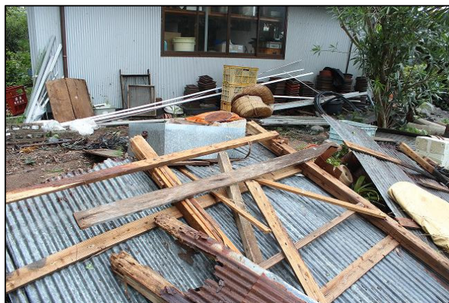
図 4 - 2 撮影場所② 北側に重なるように倒壊した倉庫
