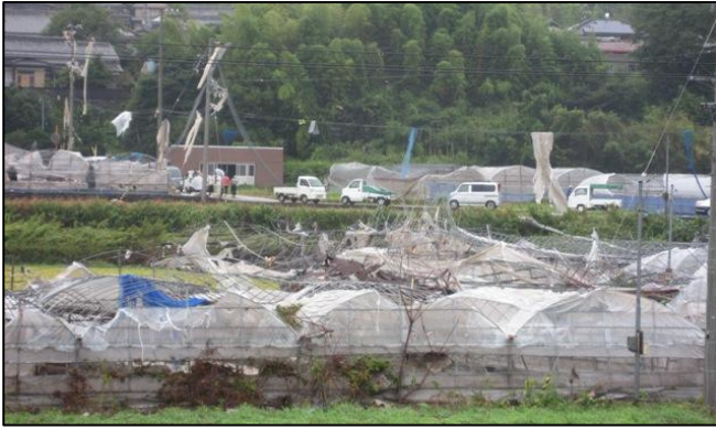
図 4 - 7 撮影場所⑦ 安芸市役所提供 ビニールが飛散したり、変形したビニールハウス
