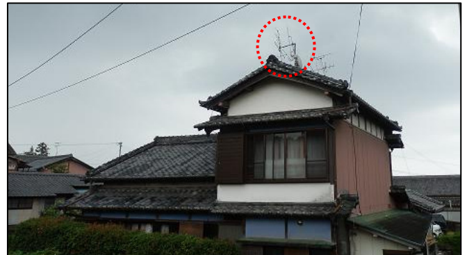
図 4 - 12 撮影場所⑫ 東に折れ曲がったテレビアンテナ
