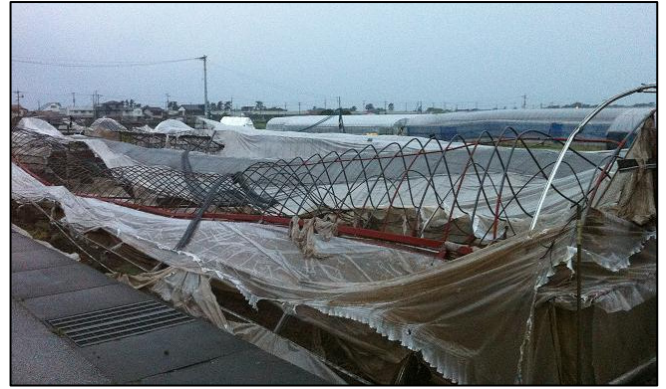
図 4 - 8 撮影場所⑧ 安芸市役所提供 ビニールが飛散したり、変形したビニールハウス
