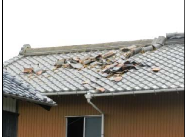
② 棟瓦ごと屋根瓦がめくれた非住家 【津市提供】 [安濃町清水]
