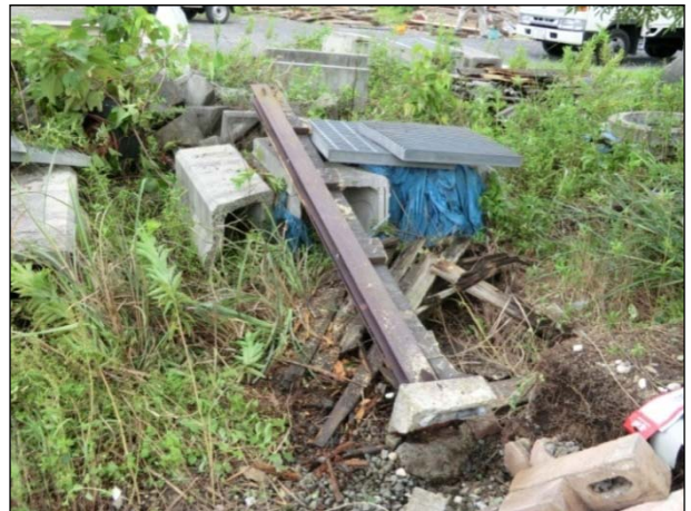
④ 飛ばされ大破した車庫の柱 [藤原町大貝戸]
