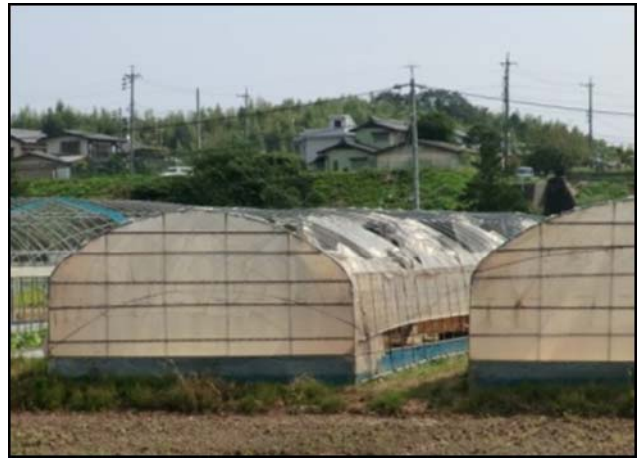
④ 一部損壊したビニールハウス [安濃町清水]
