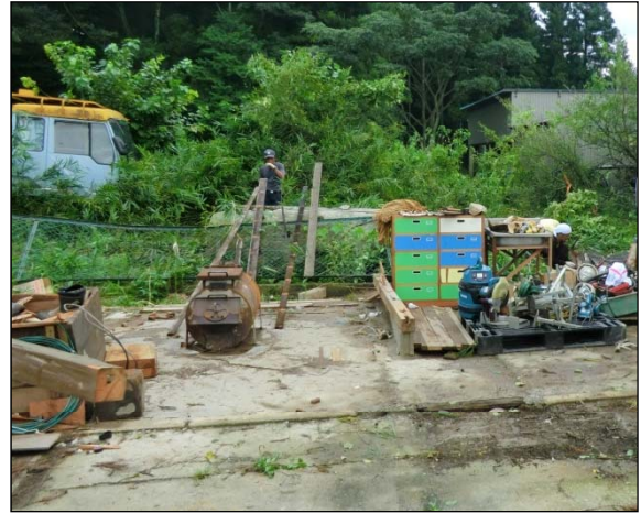
② 倒壊した非住家 [藤原町大貝戸]
