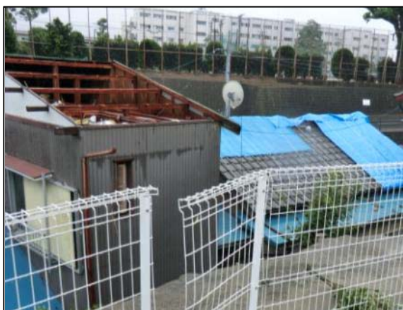
② 屋根が飛散した住家と屋根瓦が 飛散した住家(補修中) (北北東から撮影)
