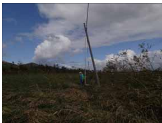
地点14（北方向を撮影） 西方向に20度傾斜した電柱
