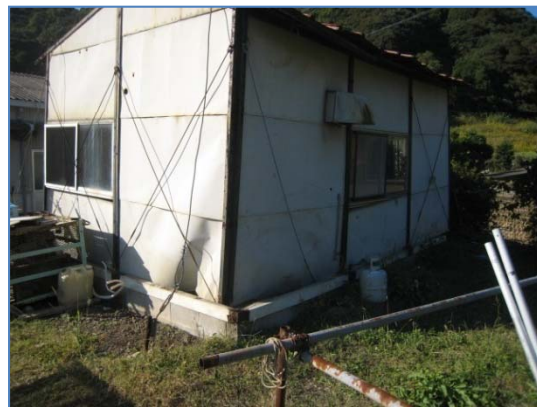
④移動したプレハブ (南東から北西に向かって撮影)
