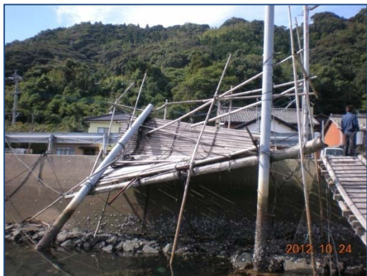
①倒れた中空構造の鉄柱 (南東から北西に向かって撮影)
