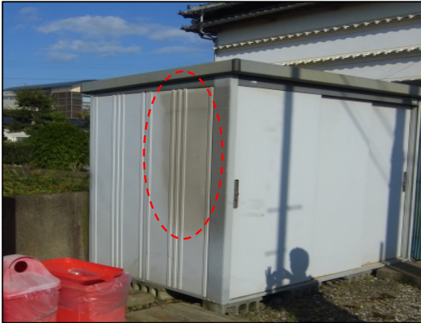
図 4 - 1 撮影場所① 側面に備え付けられていた掲示板が飛散した物置
