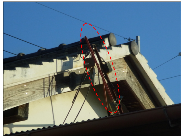
図 4 - 4 撮影場所④ 北東方向に折れ曲がったテレビアンテナ
