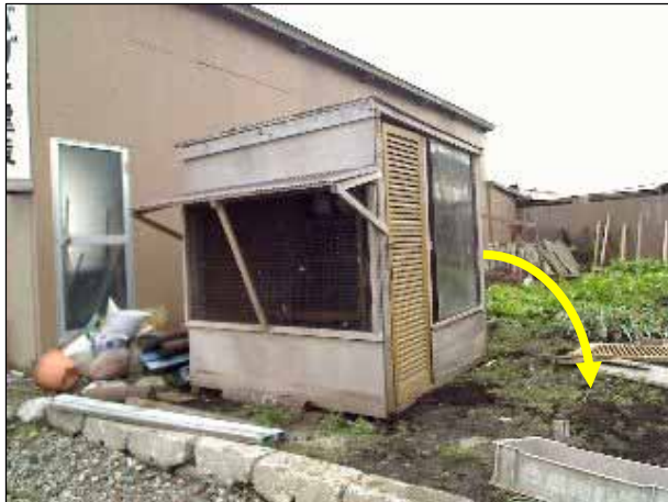
写真奥側(西側)に転倒した非住家(鶏小屋、高さ1.8m幅1.8m奥行1.8m)。写真は修復後に撮影。
