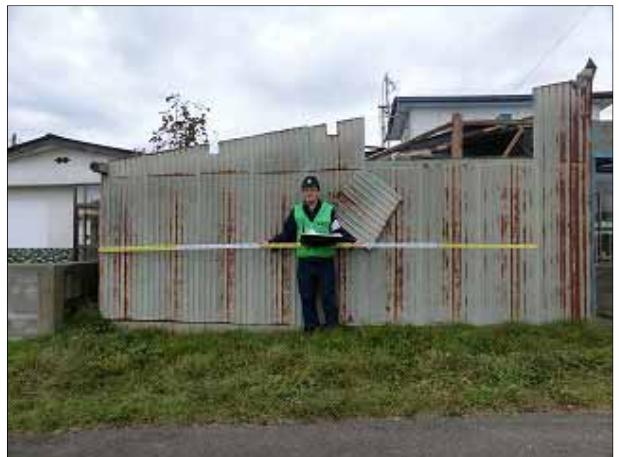
同左車庫東側から撮影
