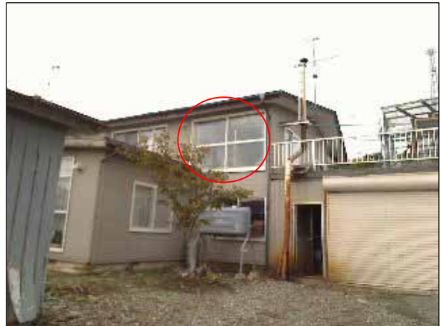
2階の南側窓ガラスが割れ、部屋の中に散在した住家。写真は修理後に撮影。
