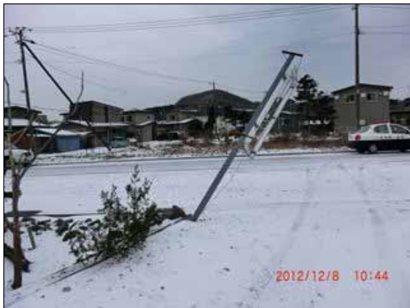
飛散物により看板が割れ、北西方向に傾いた鉄柱
