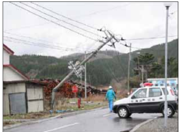
電線に引っ張られ折損した電柱 (写真：様似町提供)
