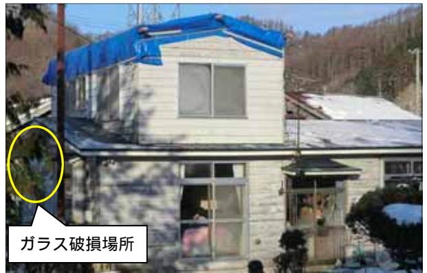
2階屋根が北東方向に飛散し南側窓ガラスが飛散物により破損した住家 （写真左側が南方向）
