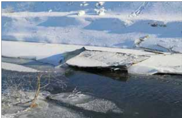
北東に約43m飛散した の住家屋根
