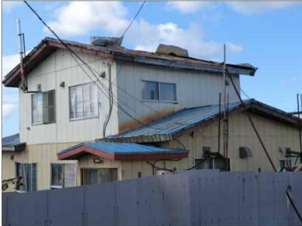
A 7 住家屋根トタンが西南西方向に一部飛散
