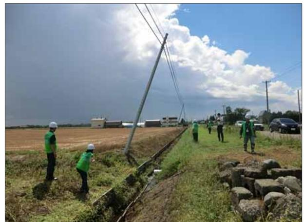
A 6 電柱3本が西北西方向に傾斜
