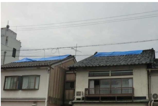
⑤ 瓦が飛散し補修中の住家 (東から撮影)
