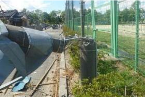
① 折れたコンクリート製の電柱 (埼玉県越谷市砂原)
