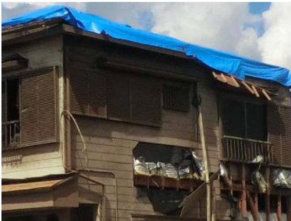
⑪ 屋根が飛散し外壁の一部も損壊した住家 (千葉県野田市岩名)
