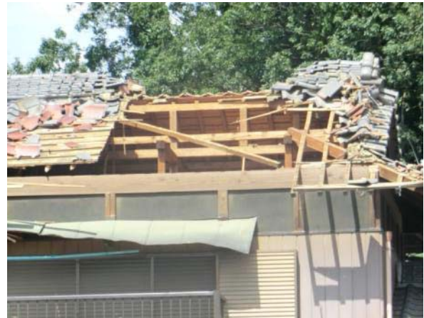
⑩ 屋根瓦が飛散し屋根下の構造材が一部損壊した住家 (埼玉県北葛飾郡松伏町築比地)
