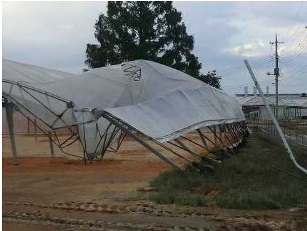
③ 一部損壊したビニールハウス （鹿沼市茂呂）
