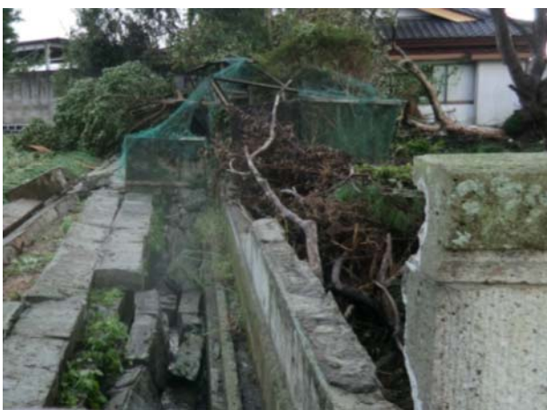
⑤ 倒木と倒壊した石塀 （矢板市川崎反町）
