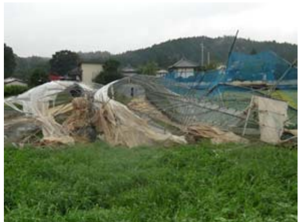
④ 倒壊したビニールハウス （矢板市川崎反町）
