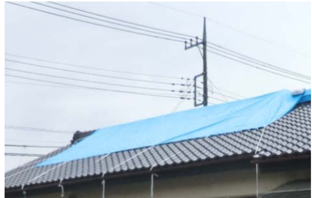
② 屋根瓦が飛散した住家（補修作業中） （鹿沼市茂呂）
