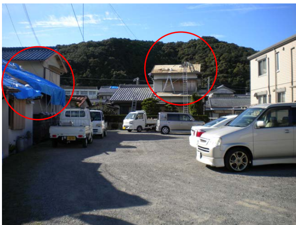
⑦ 西向地区：屋根瓦の飛散した住家
