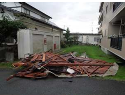
㉒飛散しアパート南側外壁にぶつかったカラオケ店の屋根 (石巻広域消防提供、東から撮影)
