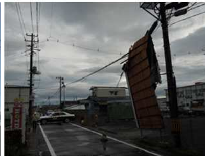
⑰中央の住家から飛散した屋根 (石巻広域消防提供、北から撮影)
