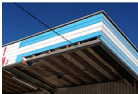
㉓一部が風圧で外側にめくれたトタン (石巻広域消防提供、西から撮影)
