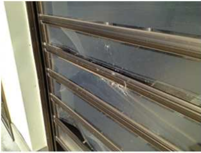
⑪スレート破片が衝突し損傷した樹脂製シャッター
