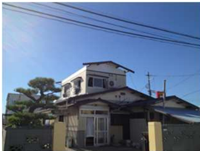
⑯屋根が支柱ごと飛散した住家 (南東から撮影)
