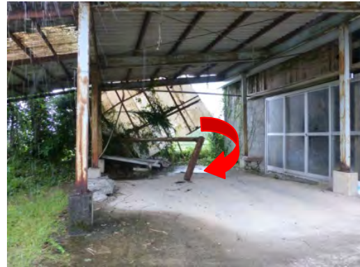
K：車庫の鉄筋フレームが手前に移動 （西側から撮影）
