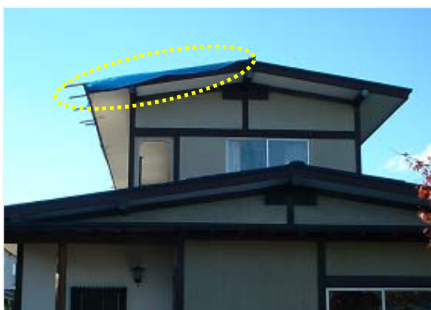
②住家のトタン屋根損壊(東から撮影)。
