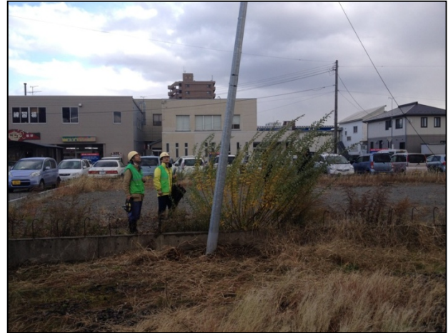
④ 南に傾いた電柱 (西から撮影)
