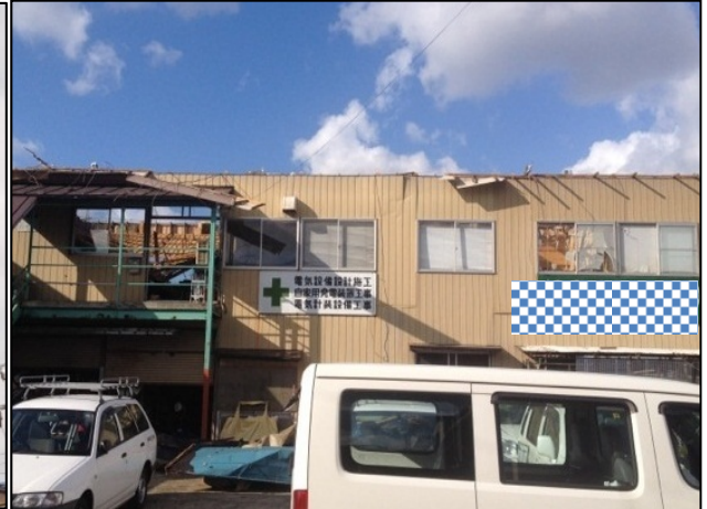
② 作業場のトタン屋根が剥離し東側の中学校の グラウンドまで飛散 (東から撮影)
