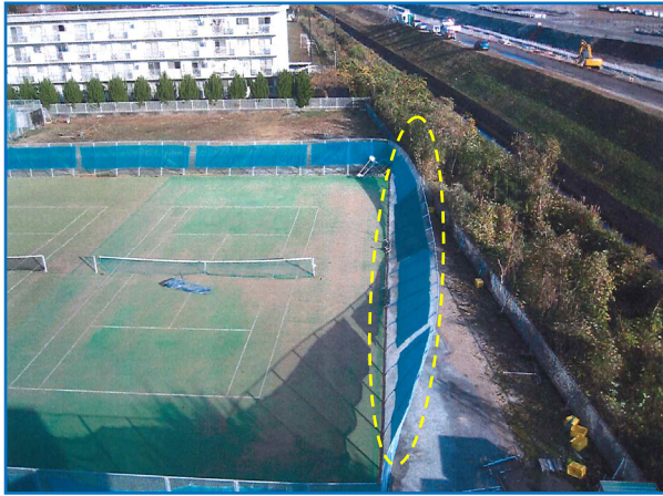
図 5-7 撮影場所 地域 A⑦ 東に傾いたテニスコートの外周フェンス (写真提供：高知工業高等専門学校)
