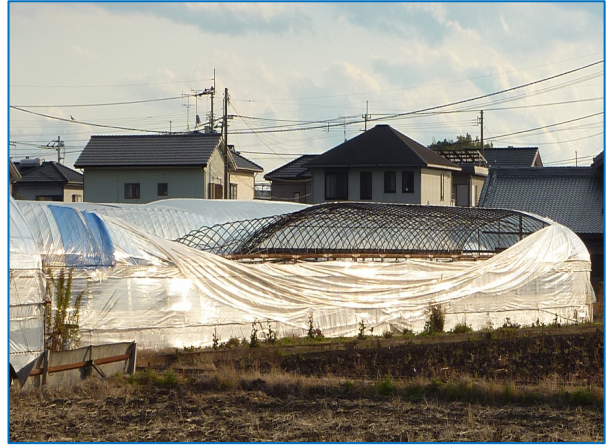
図 7-14 撮影場所 地域 C14 ビニールがめくれ、大きく変形した 11 棟のビニールハウス（写真はその一部）
