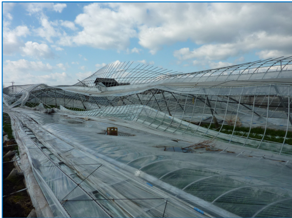
図 7-9 撮影場所 地域 C⑨ 支柱が北側に折れ曲がり、大きく変形した 2 棟のビニールハウス
