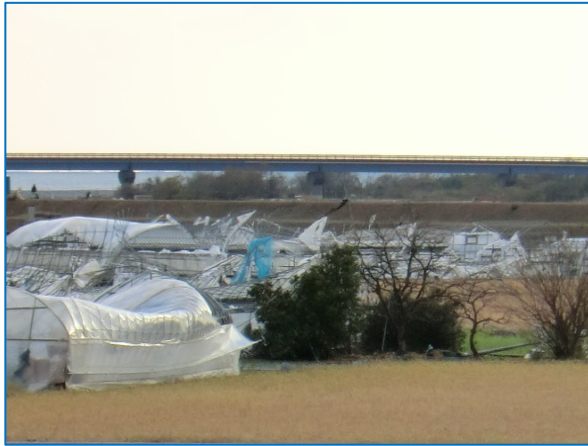
図 6-1 撮影場所 地域 B① ビニールがめくれ、大きく変形した 6 棟のビニールハウス
