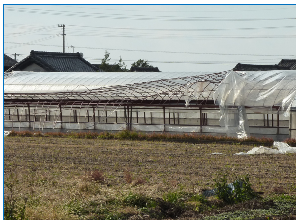
図 7-4 撮影場所 地域 C④ 東側のビニールがめくれたビニールハウス
