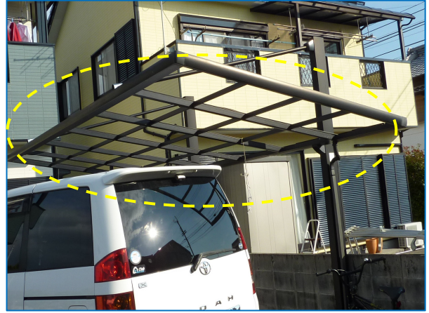
図 10-8 撮影場所 地域 F⑧ アクリル板が全て飛散したカーポート
