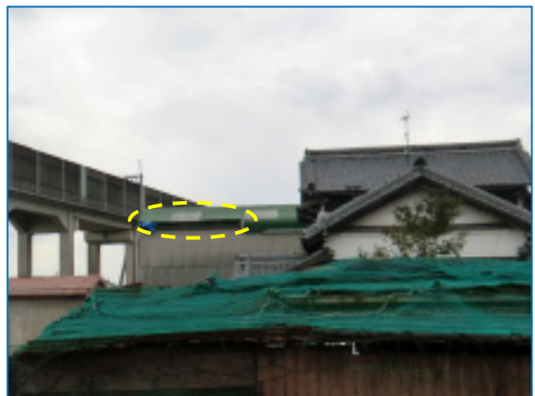
図 8-4 撮影場所 地域 D4 東面のスレート屋根の一部がめくれた事務所
