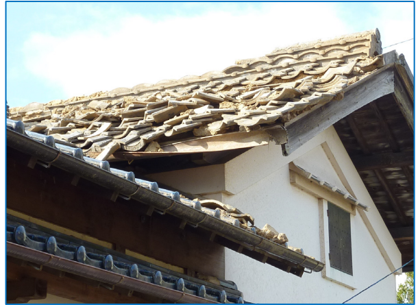
図 10-10 撮影場所 地域 F⑩ 東面の屋根瓦や棟瓦がめくれた倉庫
