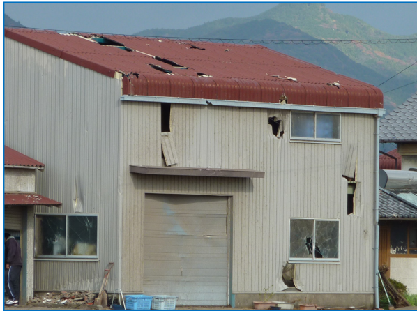
図 7-7 撮影場所 地域 C⑦ 飛散物により、壁や屋根等の一部が破損した倉庫
