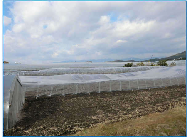
図 9-2 撮影場所 地域 E② 西から東方向に押されたように変形した 3 棟のビニールハウス（支柱なし）
