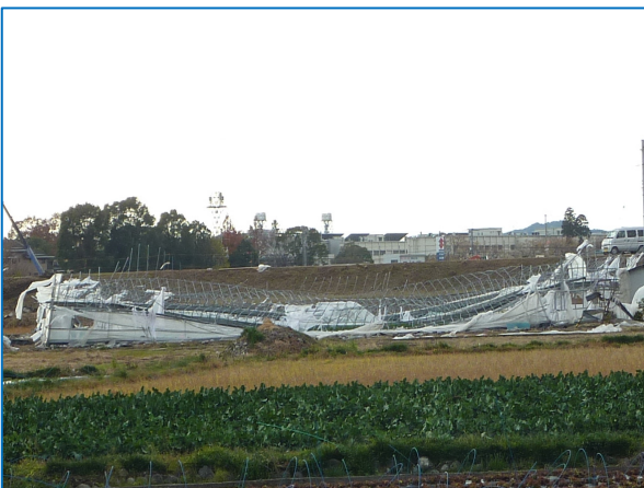
図 6-3 撮影場所 地域 B③ ビニールがめくれ、大きく変形したビニールハウス
