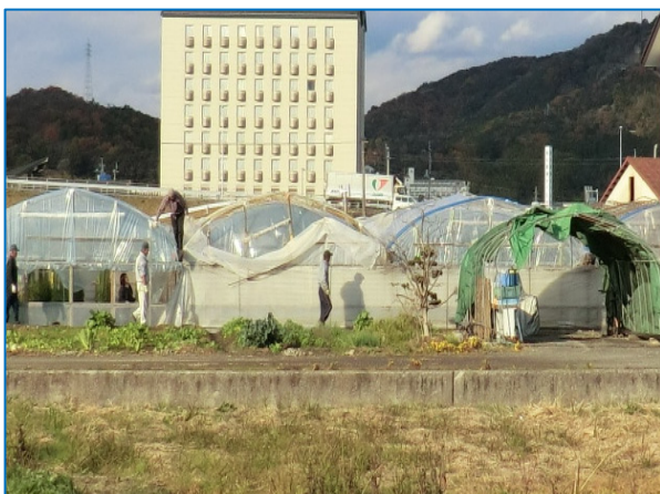
図 7-11 撮影場所 地域 C⑪ ビニールがめくれたビニールハウス
