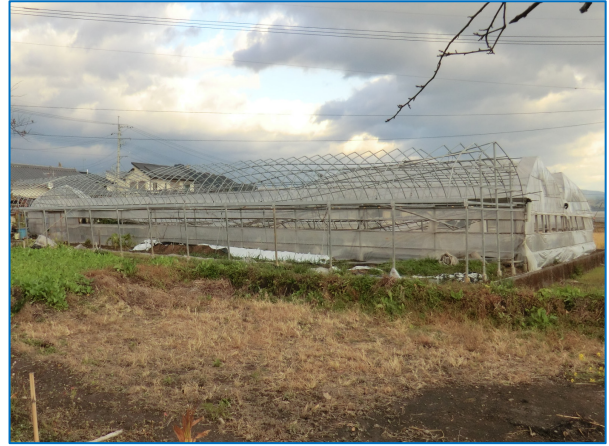
図 6-6 撮影場所 地域 B⑤ ビニールがめくれ、変形したビニールハウス
