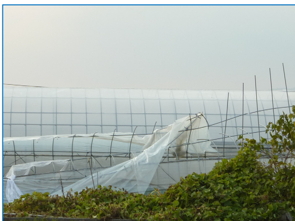
図 6-15 撮影場所 地域 B⑭ ビニールがめくれ、大きく変形したビニールハウス
