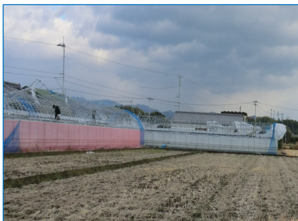
図 7-3 撮影場所 地域 C③ 骨組みの一部が変形し、ビニールがめくれた 2 棟 のビニールハウス
