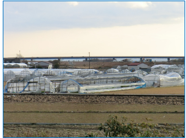
図 6-2 撮影場所 地域 B② ビニールがめくれ、変形した 13 棟のビニールハウス
