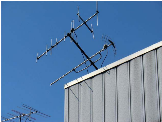
①東へ倒れたアンテナ (北東から撮影)
