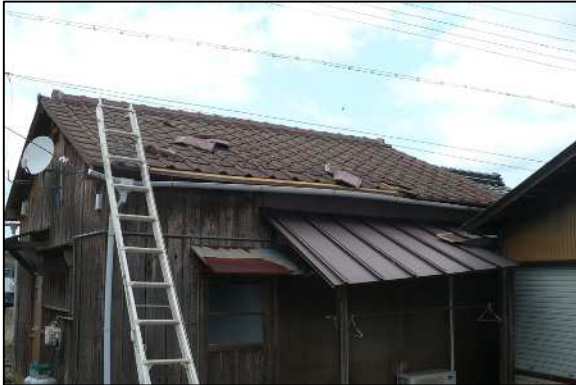
屋根瓦が一部めくれた住家 (復旧作業中)
