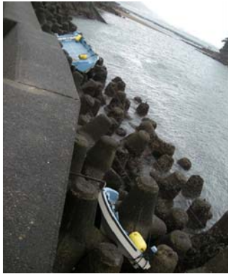
図 3-1 写真① 堤防の内側から外側のブロックまで飛ばされ大破したプレジャーボート（和歌山県東漁業協同組合提供）
