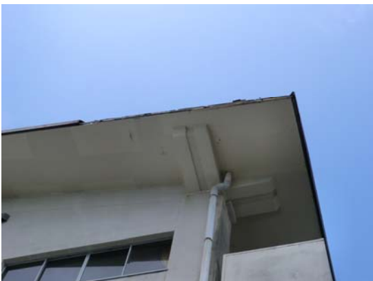
図 5-5 写真⑤ アルミ製の屋根の一部が飛散した校舎
