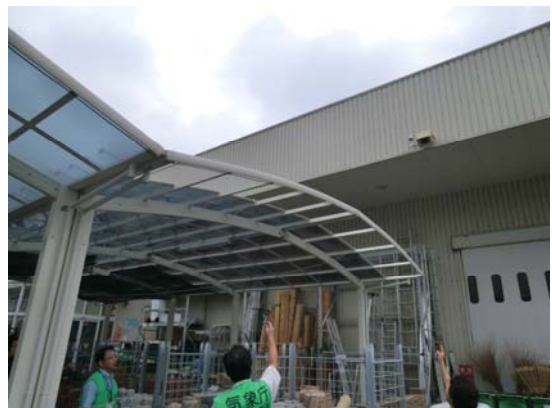
図 5-6 写真⑥ 屋根の一部が飛散したホームセンターの家庭用カーポート
