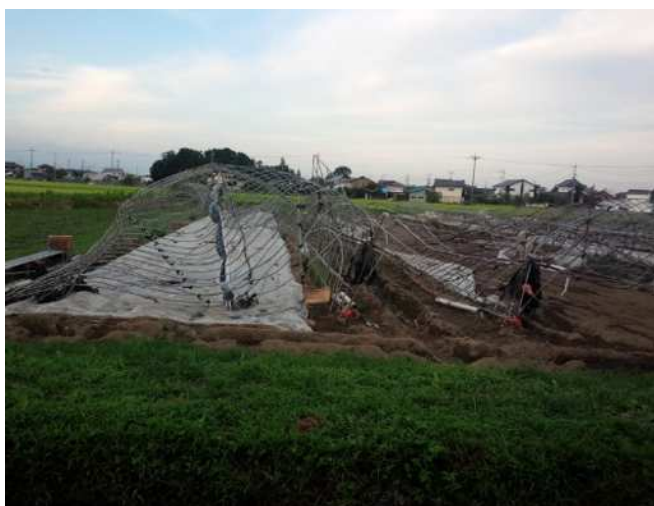
倒壊したビニールハウス （下都賀郡壬生町七ツ石）
