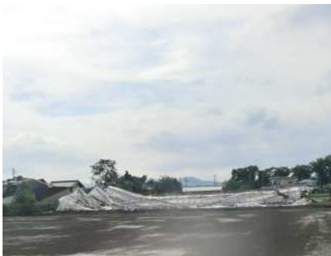
倒壊したビニールハウス （鹿沼市藤江町）
