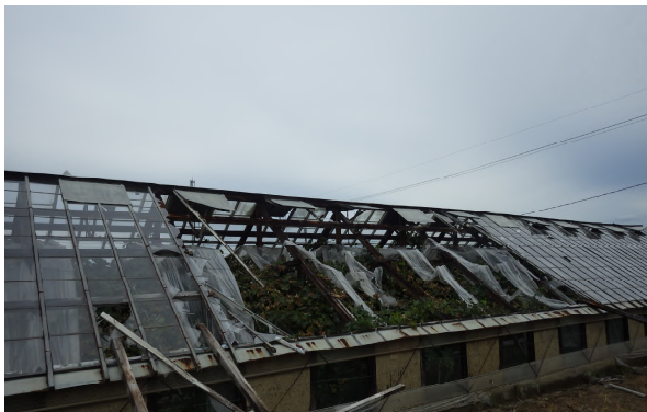
図 5-1 南東から南西にガラスが飛散した温室 撮影場所 図 4 -
