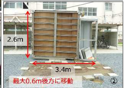
②写真(上)西から撮影 (下)北から撮影
