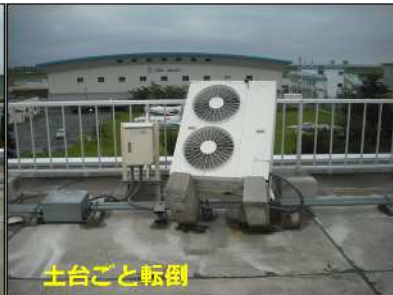
⑤横転したエアコン室外機 (左) 復旧後、(右) 転倒状況*
