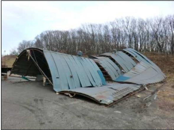
北方向へ移動・損壊した非住家（D型倉庫）
