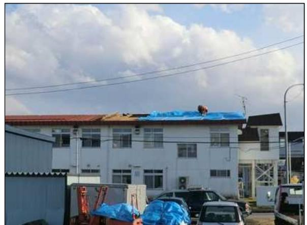
トタン屋根の一部が飛散した非住家（会社事務所、飛散した幅は約10m）
