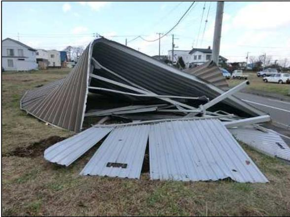
北北東方向へ25m移動し倒壊した非住家（車庫）
