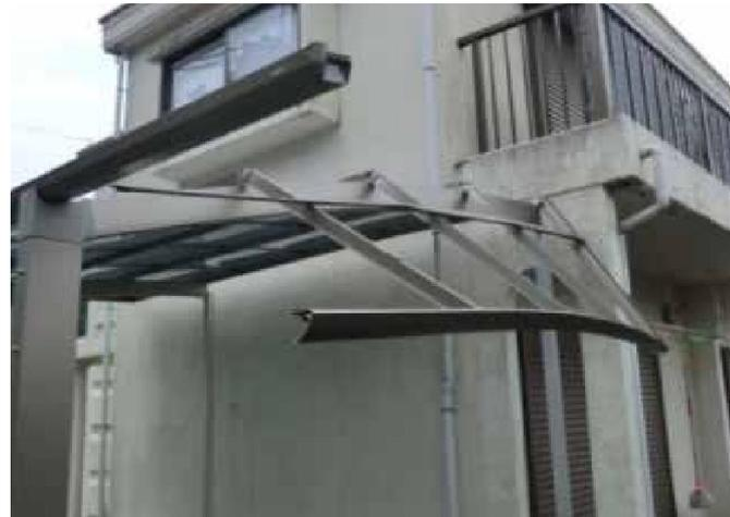
破損したアルミ製のカーポート
