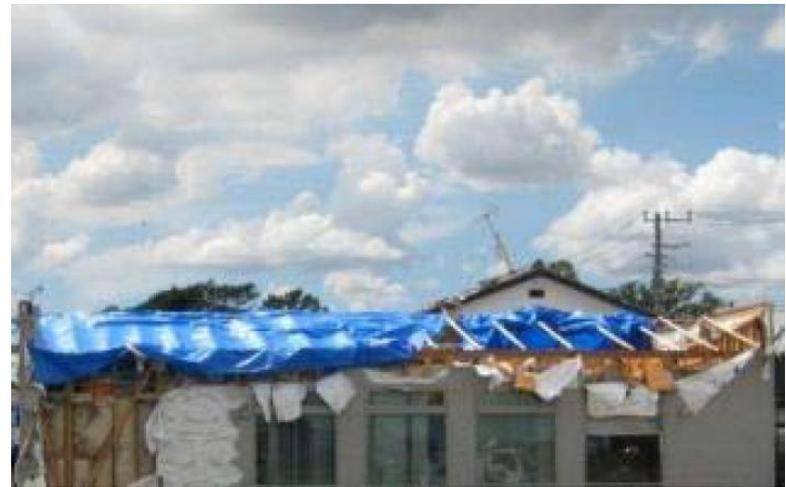
屋根が飛散し外壁が損壊した住家
