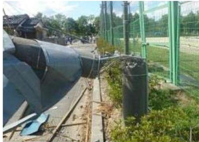
折れたコンクリートの電柱
