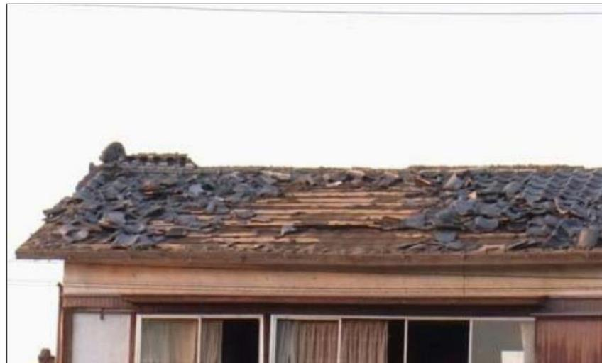
屋根瓦が飛散した住家
