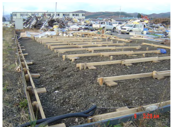
DOD=3 2階建て以上(2連以上)の転倒 手前の飛ばされていない仮設事務所と同じものが2棟(赤点線)飛ばされた。右図は飛ばされた仮設事務所の杭基礎の状況で、杭が引き抜けに対して抵抗した痕跡はない。(2層以上の連棟で短辺長さが10m以上あるので代表値を採用する事例) 写真提供：(左)東京工芸大学風工学研究センター、(右)国立研究開発法人建築研究所
