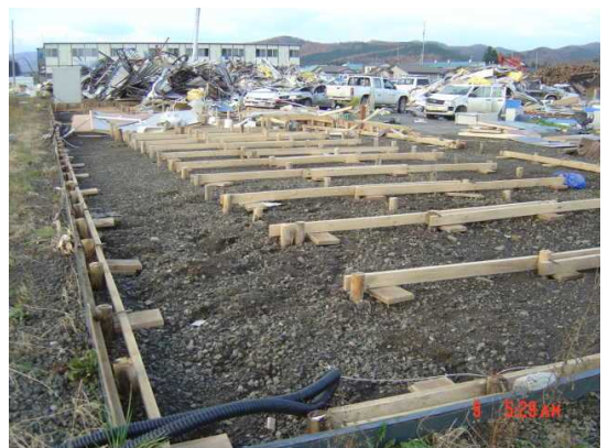
DOD=3 2階建て以上(2連以上)の転倒 手前の飛ばされていない仮設事務所と同じものが2棟(赤点線)飛ばされた。右図は飛ばされた仮設事務所の杭基礎の状況で、杭が引き抜けに対して抵抗した痕跡はない。(2層以上の連棟で短辺長さが10m未満であるので代表値を採用する事例) 写真提供：(左) 東京工芸大学風工学研究センター、(右) 国立研究開発法人建築研究所
