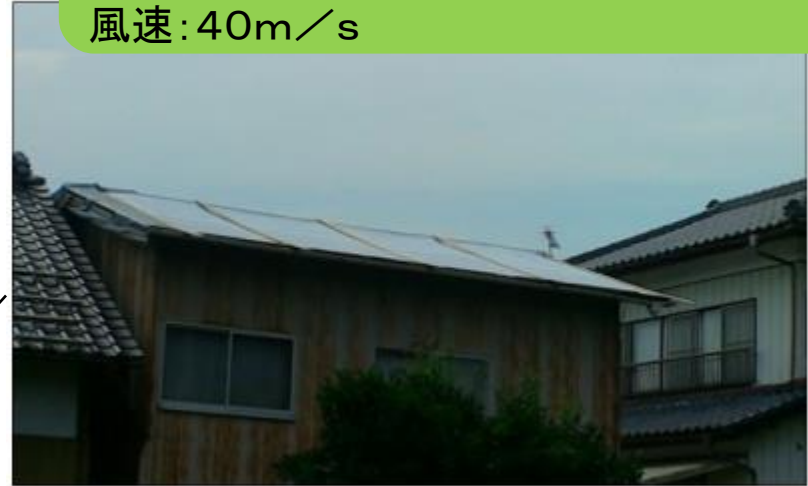
飛散箇所は修繕済み
