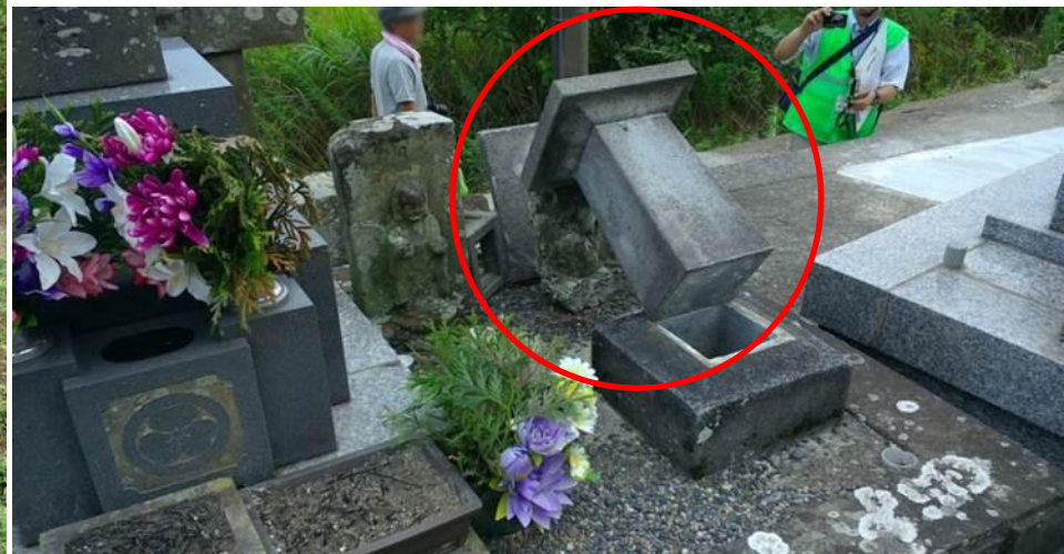
▼石灯籠が倒れ、押される形で墓石が倒れた事例
