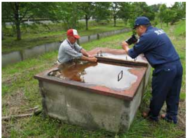
被害地点 _古井戸のふた ( 1 枚約 50Kg x 2、 鍵がねじ切れ 5m 南に飛んだ。 )
