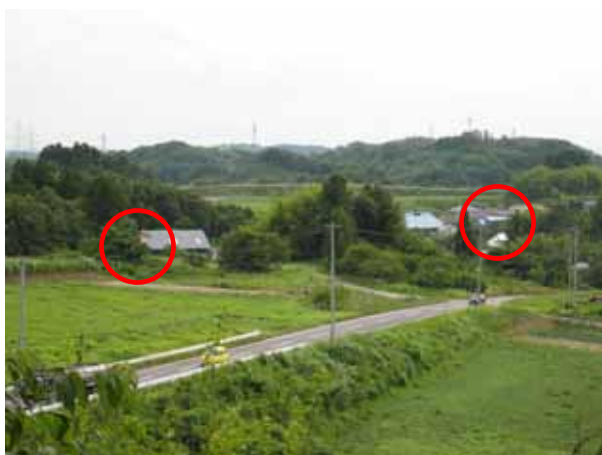
B 地点_被害地点 から遠景 左円は屋根のトタンが一部破損。右円は被害地点 （撮影：北 南）
