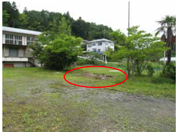
被害地点 _プレハブ小屋の飛散跡地 ( 撮影：南東 北西 )
