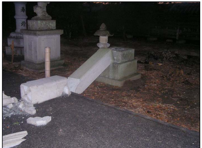
④ 倒壊した灯籠 (南東から撮影) 【松崎町】
