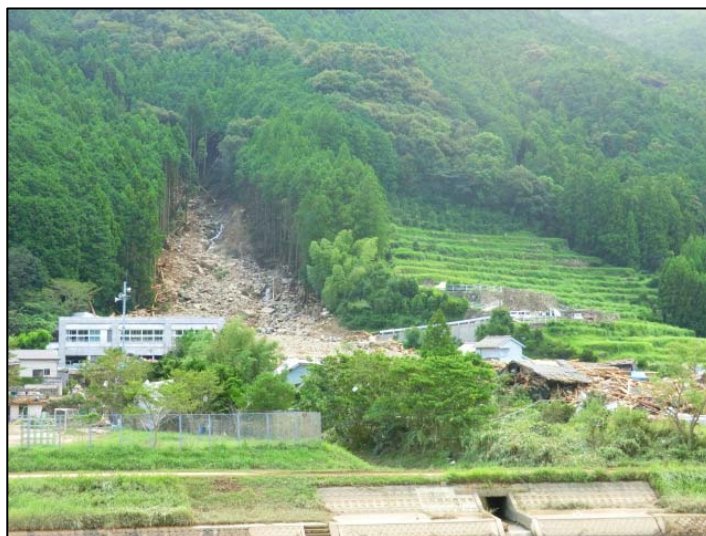
写真 明和小学校裏の土砂崩れ（高岡地区）
