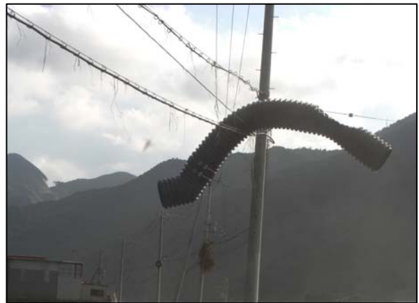
写真 増水により電線にかかった漂流物
