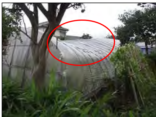
③：へこんだビニールハウス（南東から撮影）
