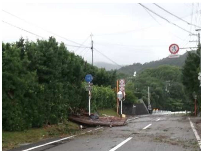
約40m飛んだ小屋の側壁 【熊野市消防本部提供】
