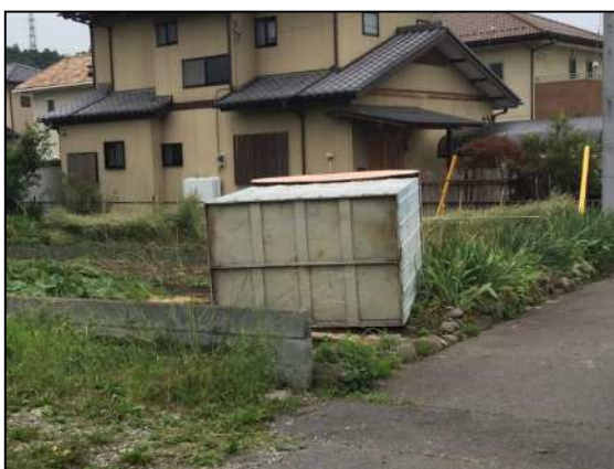
転倒したプレハブ小屋 （北から撮影）
