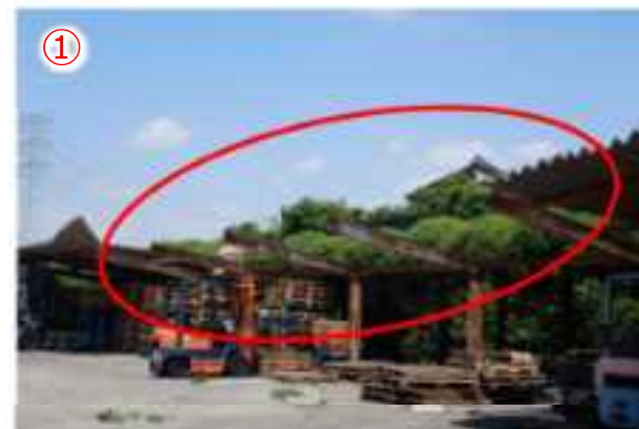
65m/s DI5,DOD3,下限値 採用せず (突出値) 独立上屋の狭い範囲の屋根ふき材の剥離
