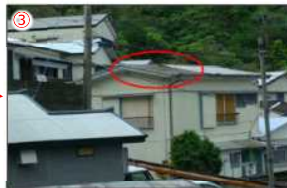
40m/s DI1,DOD2,代表値 木造住宅の屋根ふき材の飛散 (25%以下)
