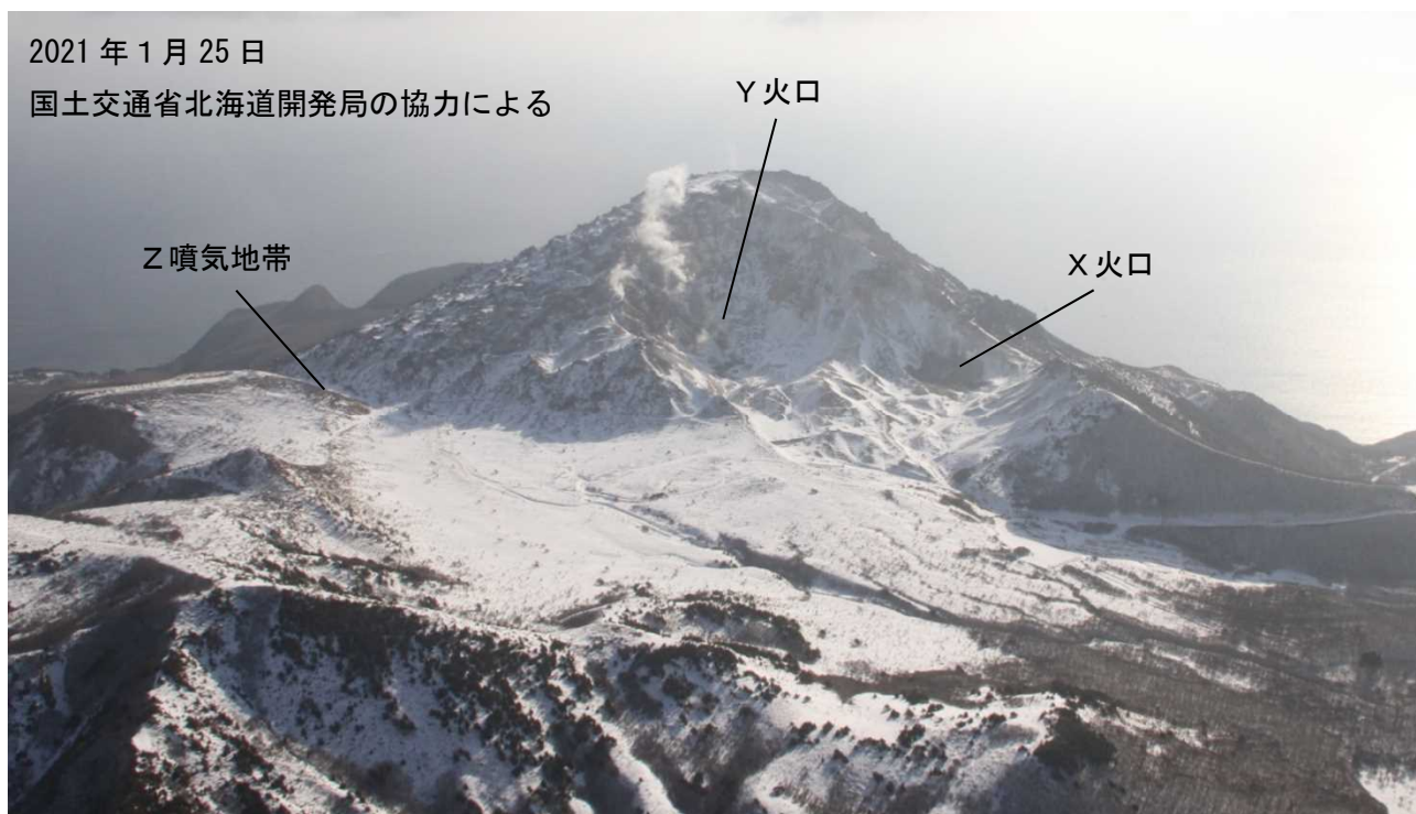
図4 恵山 火口周辺の状況 北西側上空（図3の①）から撮影
