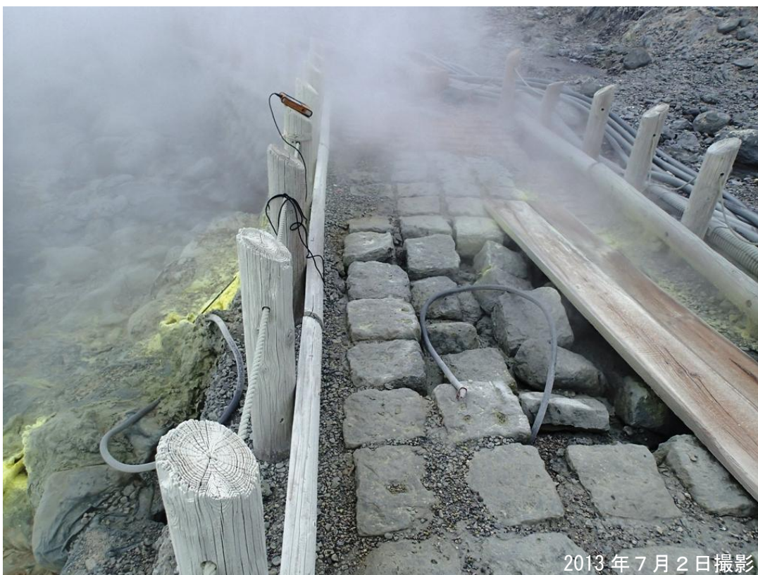
図 3 弥陀ヶ原 地獄谷遊歩道の状況
