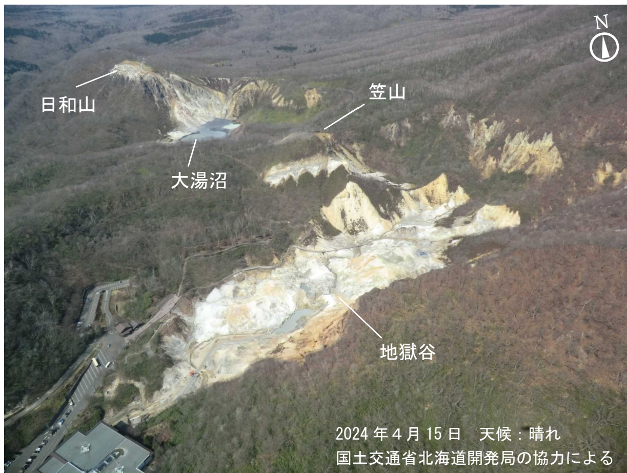
図3 倶多楽 日和山、大湯沼及び地獄谷周辺の状況 南側上空（図4の①）から撮影
