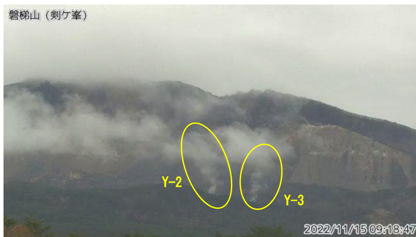
図1 磐梯山 山体北側火口壁の噴気の状況（11月15日）
